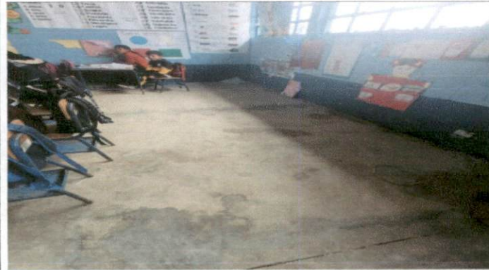
Foto 3: Sustitución de piso de granito
