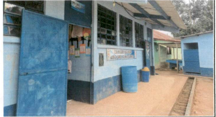
Foto 4: Sustitución de piso de granito
