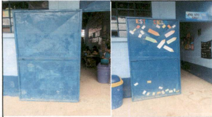
Foto 1: Mantenimiento a estructura (lijado, cambio de tubo , cepillado, ujeciones, aplicación de pintura).
