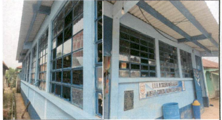
Foto 2: Sustitución de vidrios
