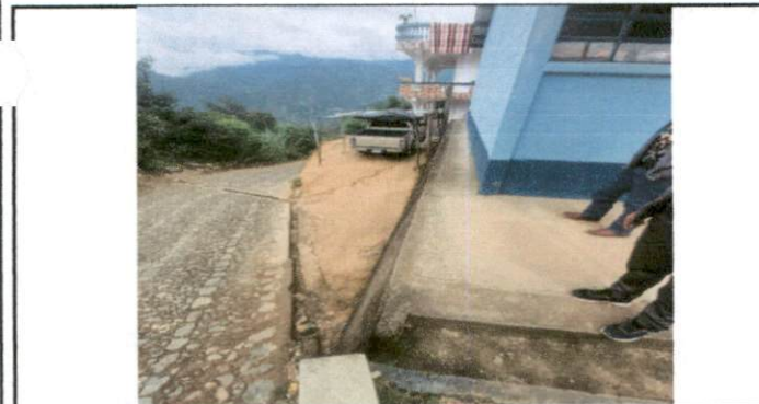
Foto 5: Sustitución de barandas de metal.
